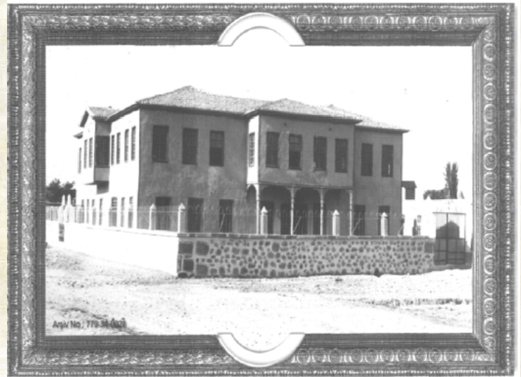
Yıkılmış Gureba Hastanesi (Arka Cephe)
